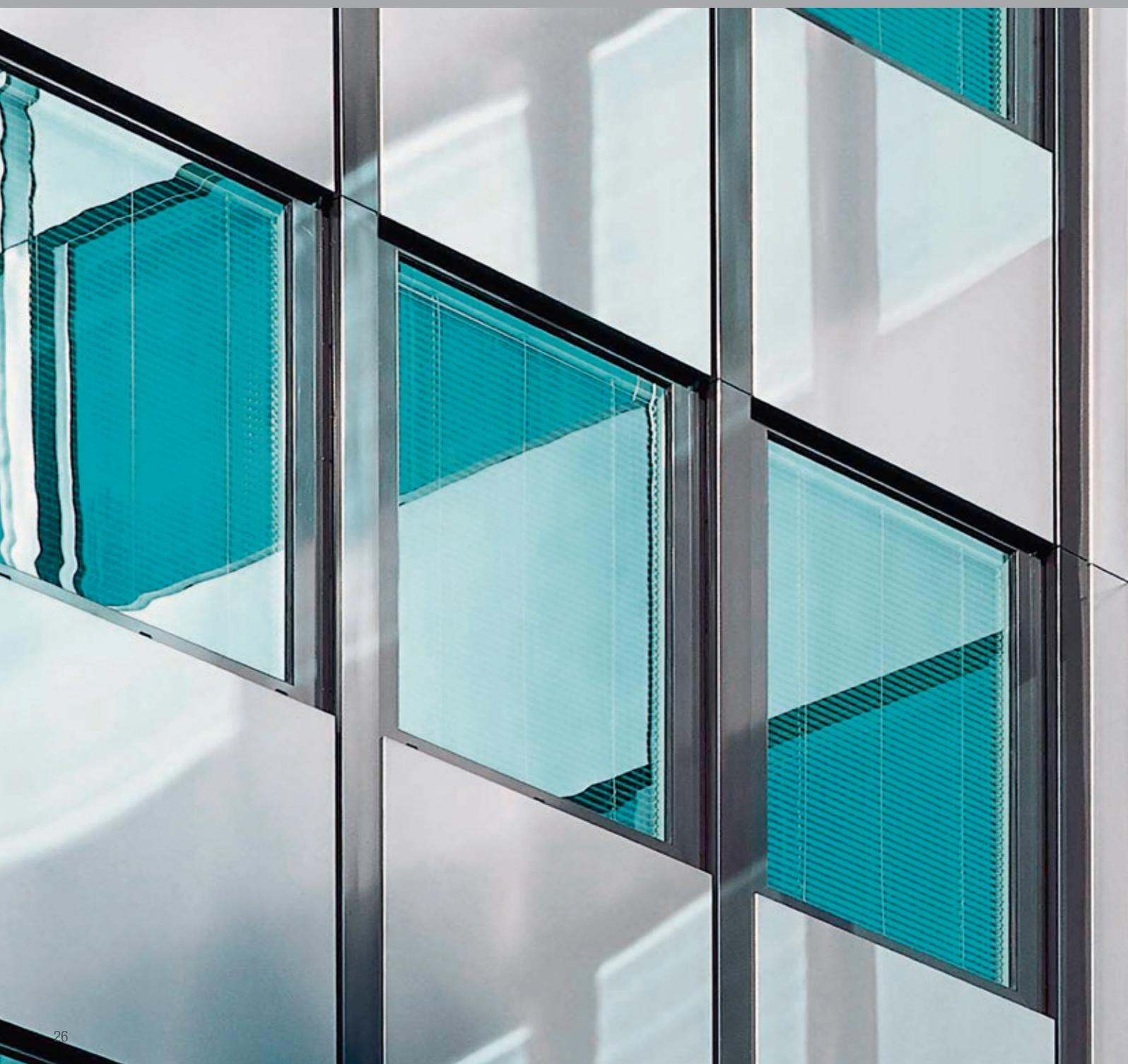
Le système de fenêtres respirantes WICONA permet l'installation « plug and play » simple et fiable du système de protection solaire électrique entre l'ouvrant extérieur et intérieur. Protégé des intempéries et du vent, le système de protection solaire peut être utilisé quelles que soient les conditions météorologiques.
